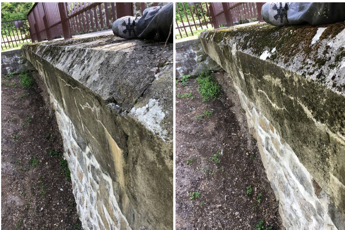
Obrázek 234 a 235 - Pohled na bet. římsu z bloku č. 90 (vlevo) a na bet. římsu z bloku č. 93 (vpravo)
