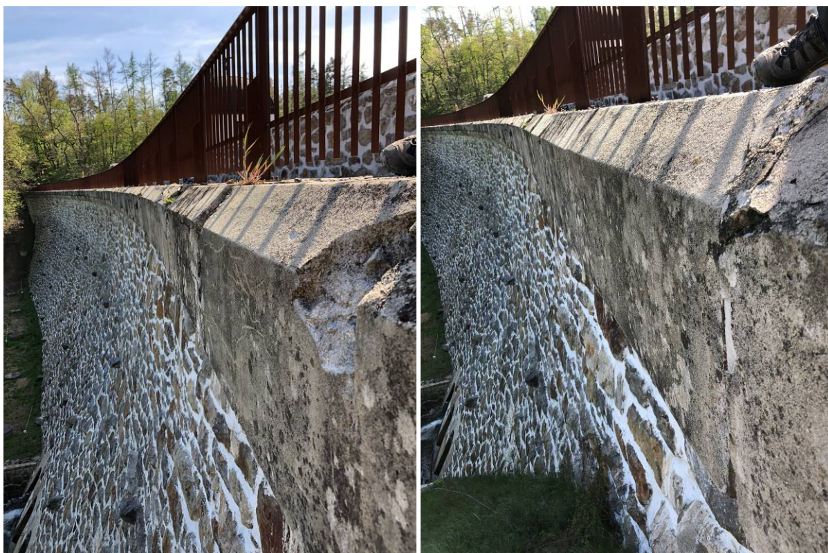
Obrázek 204 a 205 - Pohled na bloky bet. římsy 1, 2, 3 (vlevo) a na bet. římsu z bloku č. 3 (vpravo)
