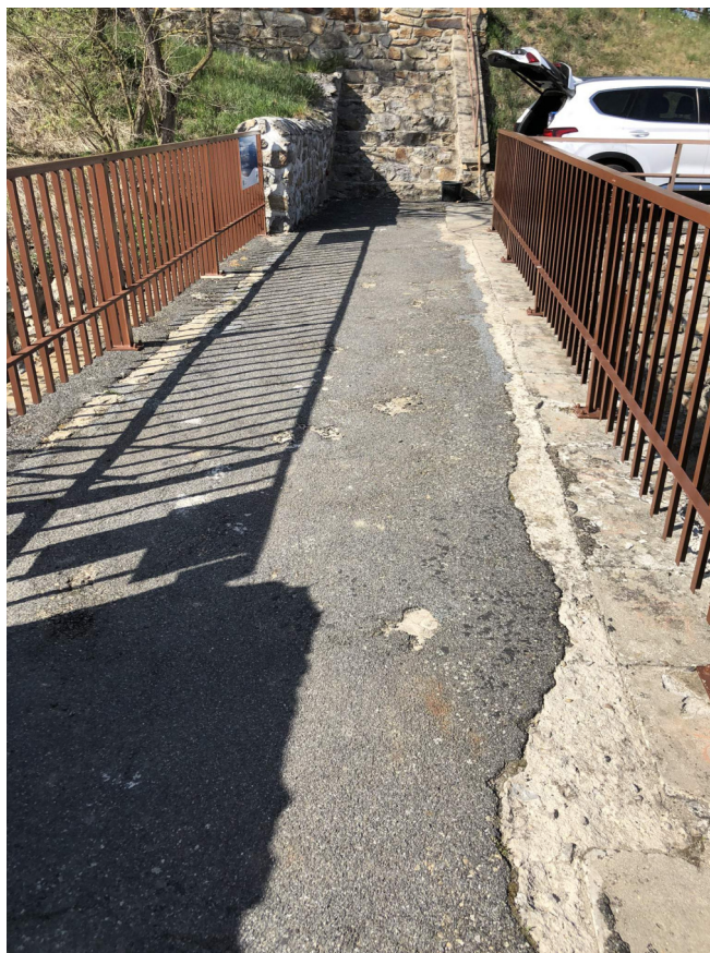
Obrázek 3 - Pohled z koruny hráze - vlevo cihlová římsa, vpravo menší bet. bloky římsy č. 1-16
